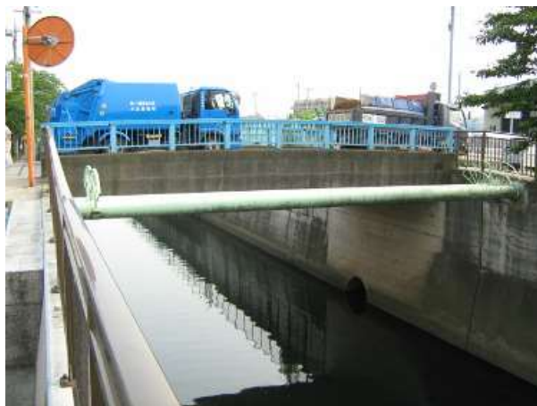
水道橋（和光市）
