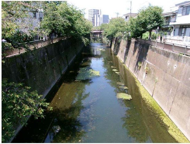
石神井川 ①久保田橋付近 久保田橋上より上流方向
