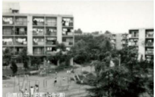
向原住宅（昭和39（1964）年頃） 出典：板橋区公文書館所蔵向原地区写真資料
