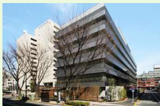
板橋区役所（本庁舎南館・北館）／板橋二丁目
