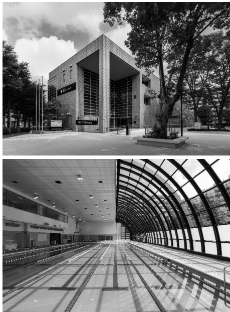
大規模改修時にUDチェックを行った 植村記念加賀スポーツセンター
