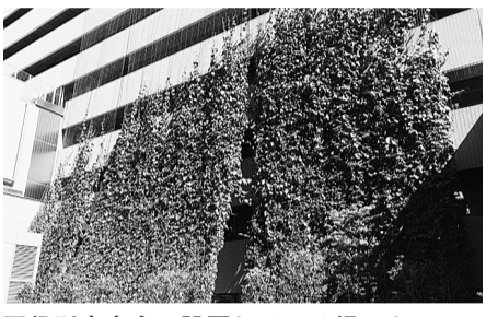
区役所本庁舎に設置している緑のカーテン
