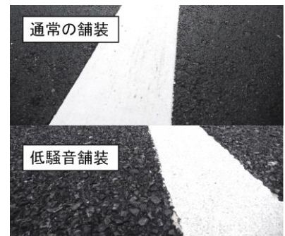
■低騒音舗装■ 車が走行する際の接地音やエンジン音の路面反射を吸収・低減させます。
