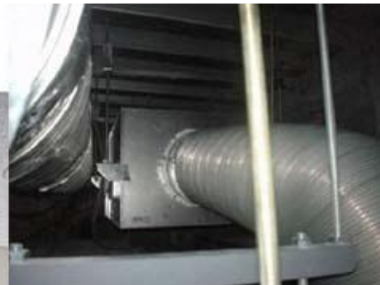
天井裏に排気装置を増設
