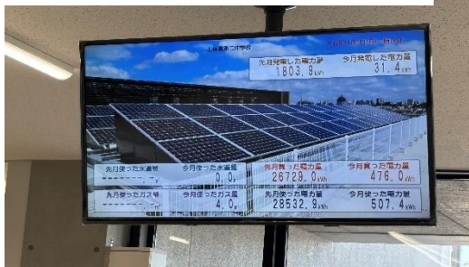
発電量がわかる掲示板の設置
