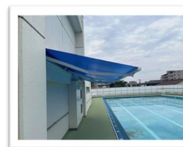
日除け(プール)
