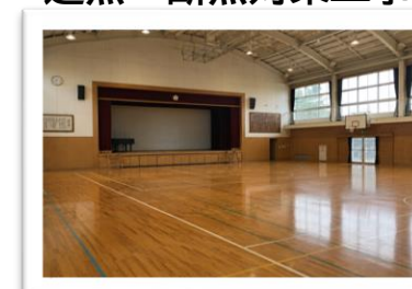
遮熱・断熱対策工事
